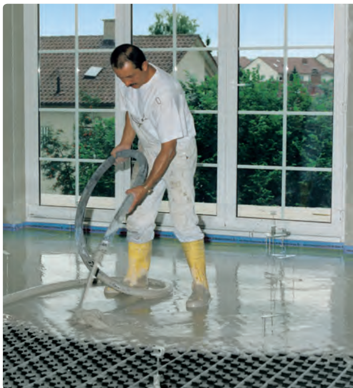
Gietvloeren kunnen zijn opgebouwd op anhydriet- of cementbasis.
